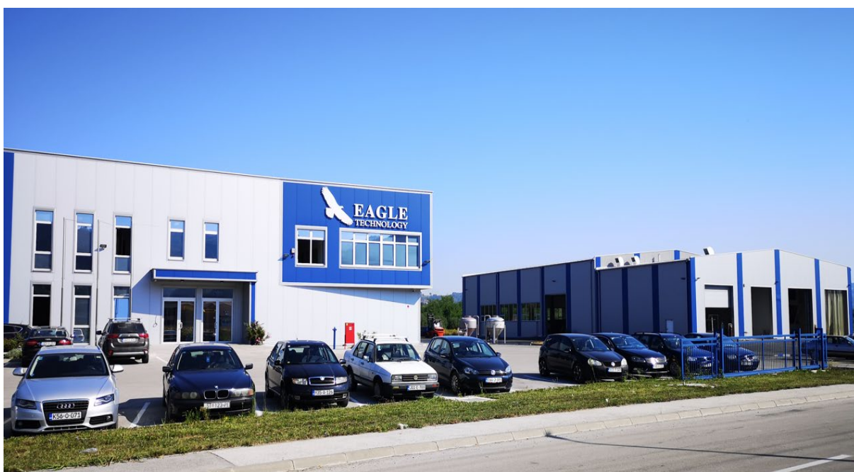
Nytt tilbygg, til høyre, tatt i bruk september 2021. Eagle Technology sin fabrikk i Zepce i Bosnia har nå ca 4200 kvm til disposisjon med fabrikasjon med eget bygg for karbonstål, overflatebehandling og lakkering. Maskinparken er topp moderne med blant annet den mest avanserte fiberlasermaskinen som er tilgjengelig på markedet.
